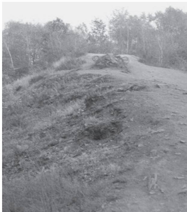
Fot. 5. Strefy zagrożone pożarami na zwałowisku Ema (fot. Ł. Gawor)
