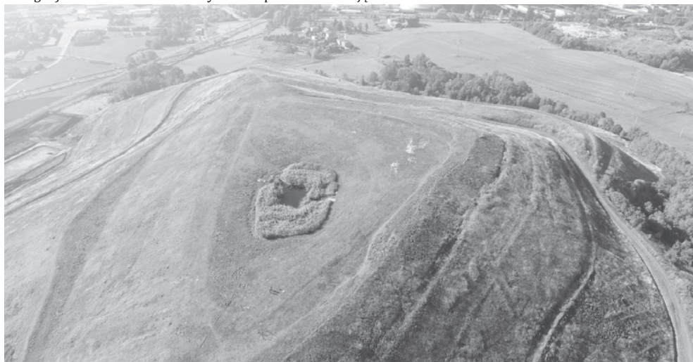
Fotografia 2. Zwałowisko Skalny – niskopoziomowe zdjęcie lotnicze
