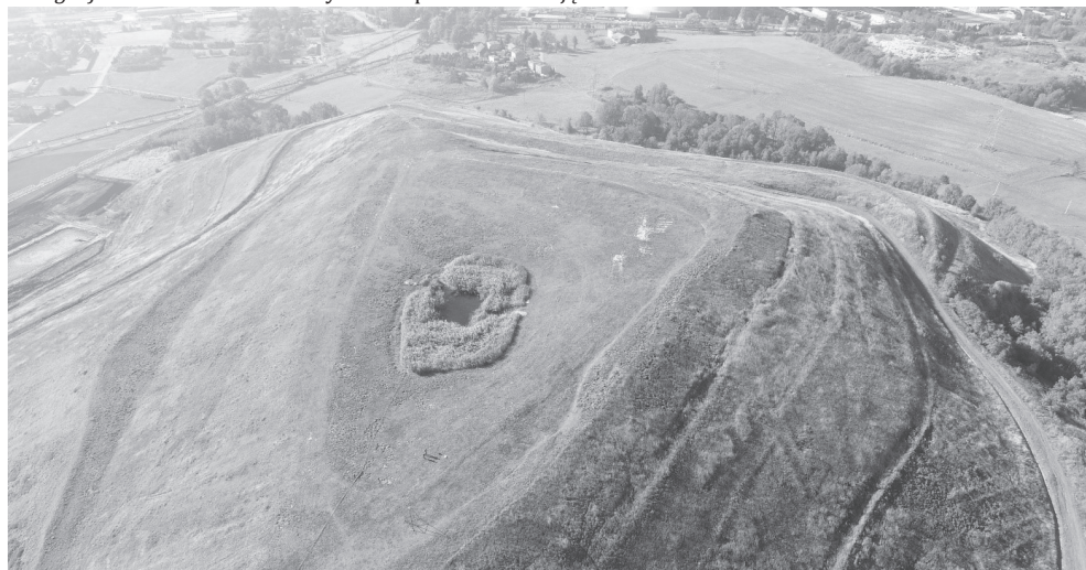
Fotografia 2. Zwałowisko Skalny – niskopoziomowe zdjęcie lotnicze
