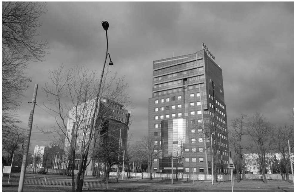
Fotografia 1. Zabudowa biurowa przy ul. Strzegomskiej we Wrocławiu
