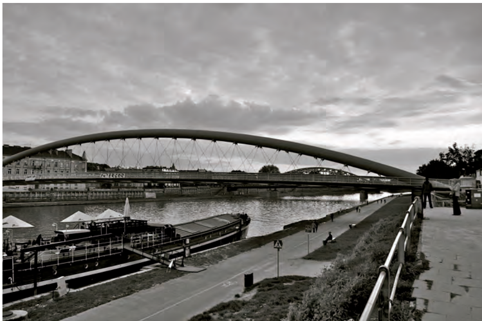
Fot. 2. Kładka pieszo-rowerowa przez Wisłę
